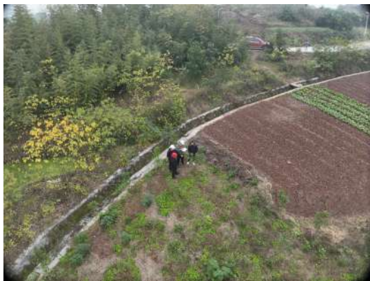
HS2#弃渣场排水沟
