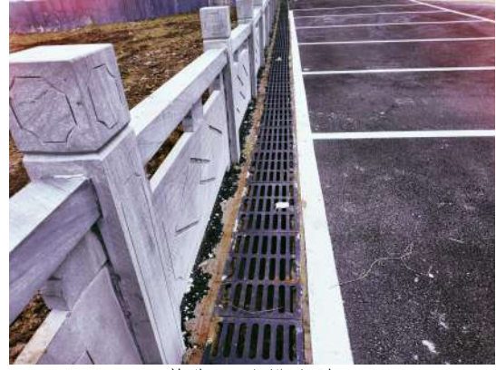
草街泵站排水沟
