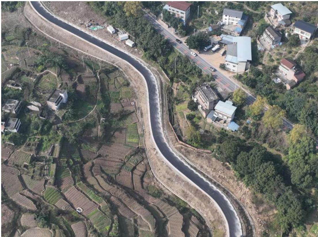
草街泵站进场道路
