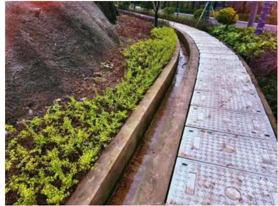
盐井河泵站排水及绿化
