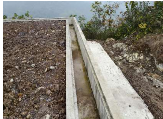
卢家坡高位水池排水沟及复耕
