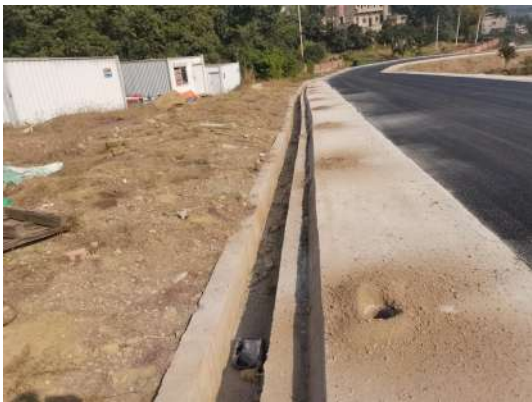
草街泵站进场道路排水沟
